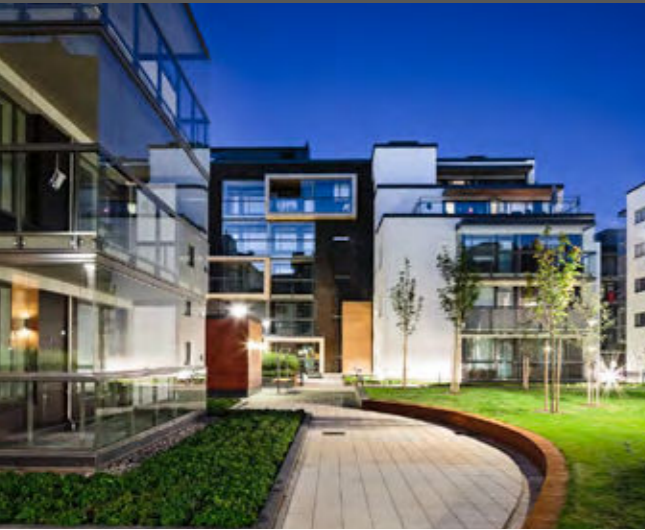
Façades de balcon
